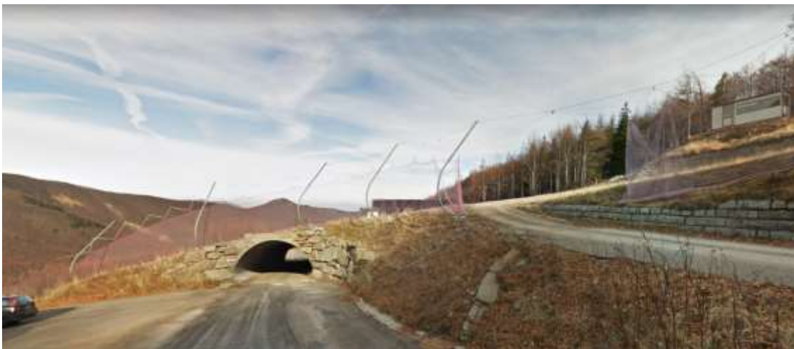
Figura 41 – Galleria lungo la SP71 – tratto a monte, in direzione Vidiciatico
