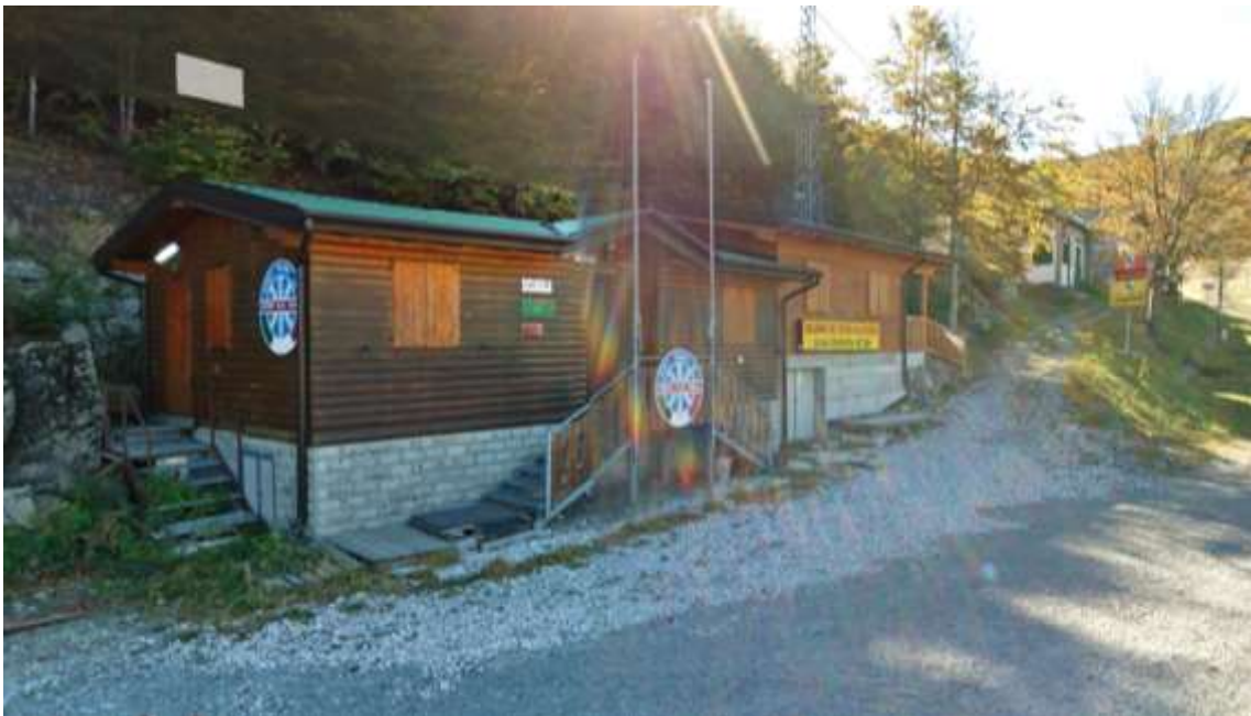
Figura 61 – Edificio che ospita la scuola di sci e il punto noleggio in loc. La Polla
