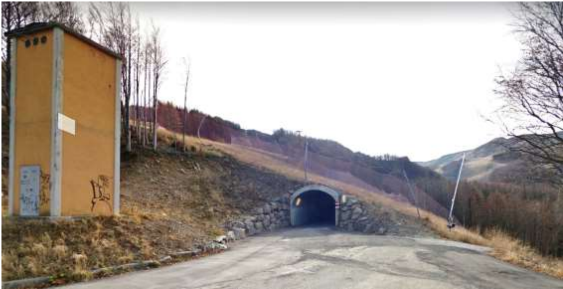
Figura 42 - Galleria lungo la SP71 – tratto a valle in direzione Corno alle Scale
