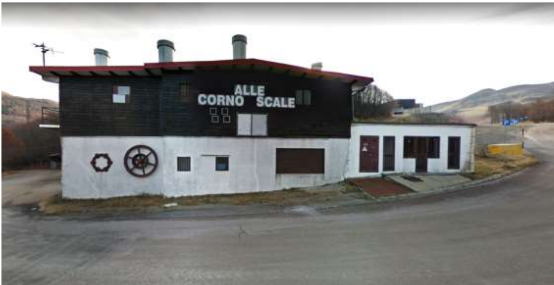
Figura 63 – Edificio principale per la rimessa dei mezzi e delle attrezzature, in loc. Lo Chalet (ex stazione di partenza del vecchio impianto di risalita)
