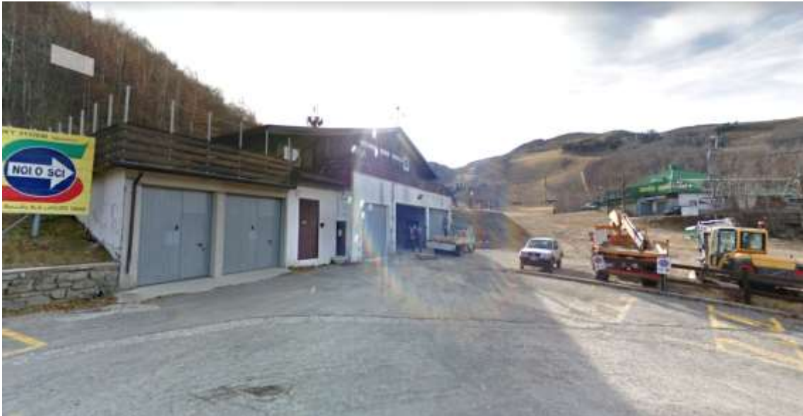
Figura 60 – Vista del lato posteriore dell'edificio (piano primo e terra-seminterrato)
