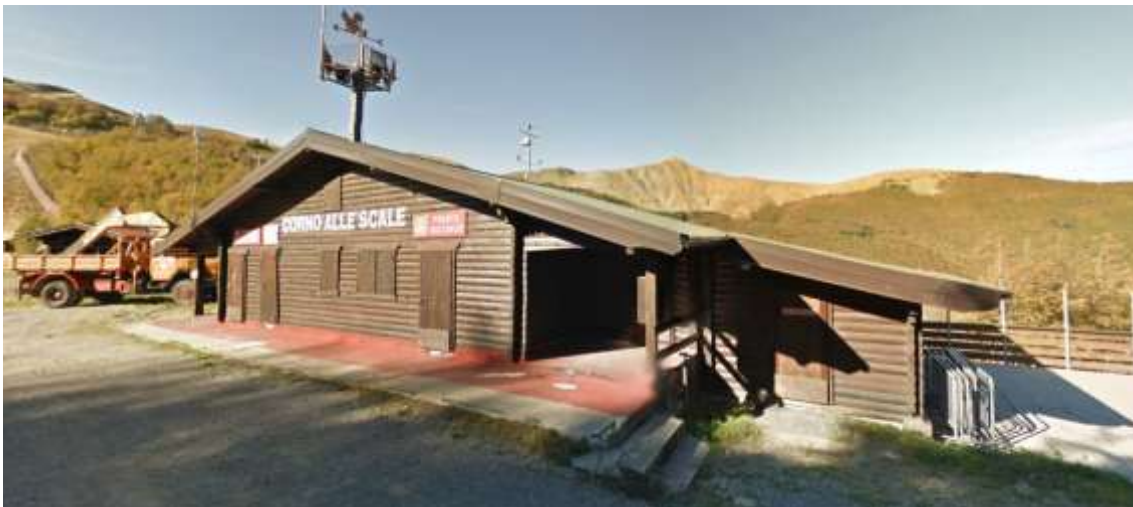
Figura 59 – Vista del fronte dell'edificio (piano primo)
