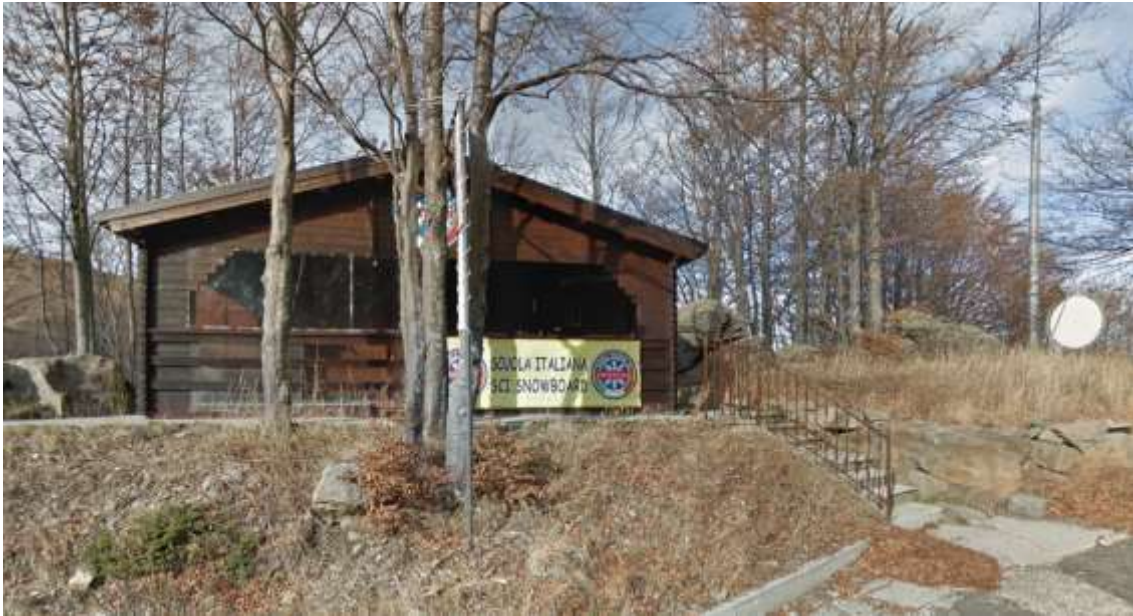
Figura 62 – Piccolo edificio che ospita la scuola di sci snowboard (web)
